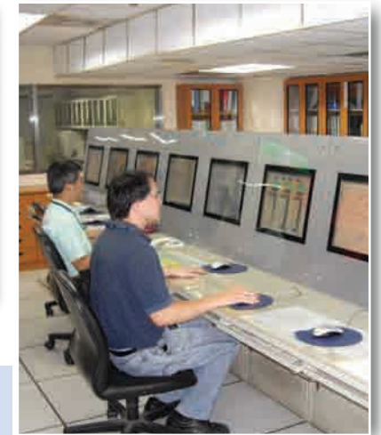
中央監控中心-能源管理
