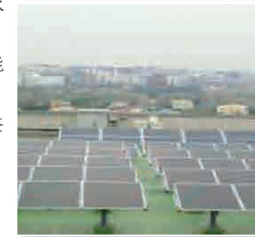
太陽能發電系統
