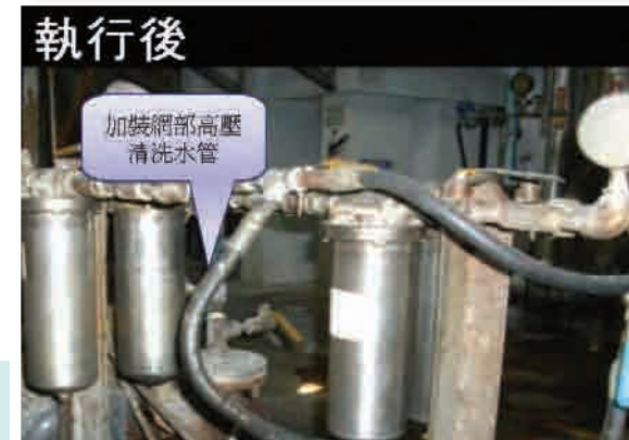
製程改善-加裝網部高壓清洗水管
