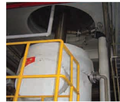
蒸餾塔熱能回收改善-1
