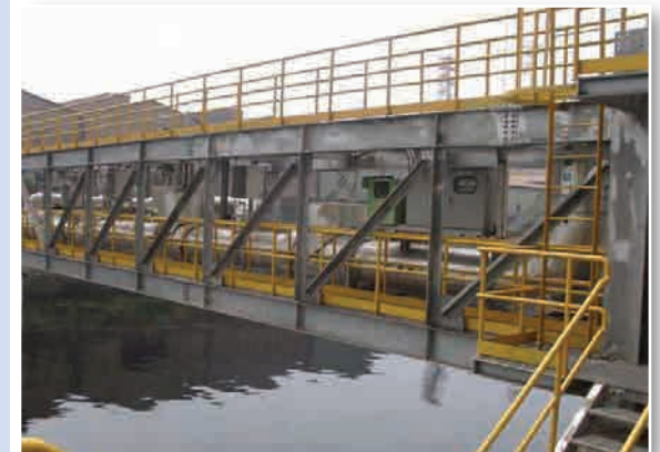
區域能源整合外售中石化公司蒸汽管線及管橋
