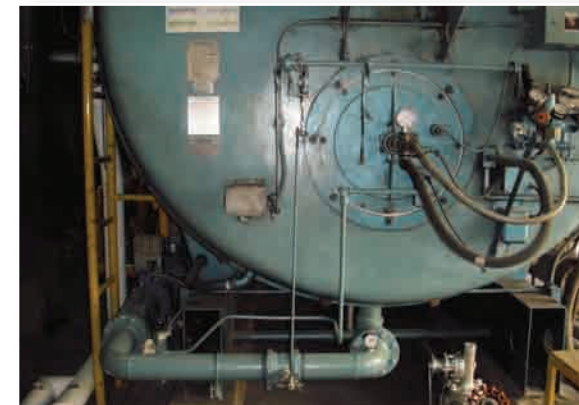
鍋爐改用天然氣取代燃料油及管線
