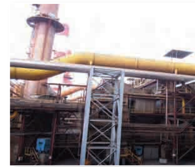
使用輔助燃料焦爐氣鍋爐
