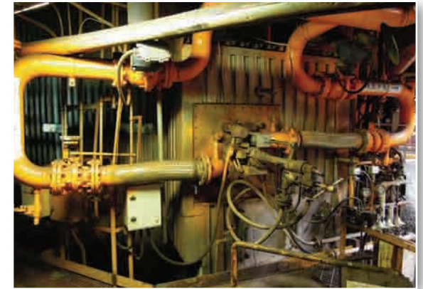
鍋爐輔助燃料焦爐氣燃燒器及管線
