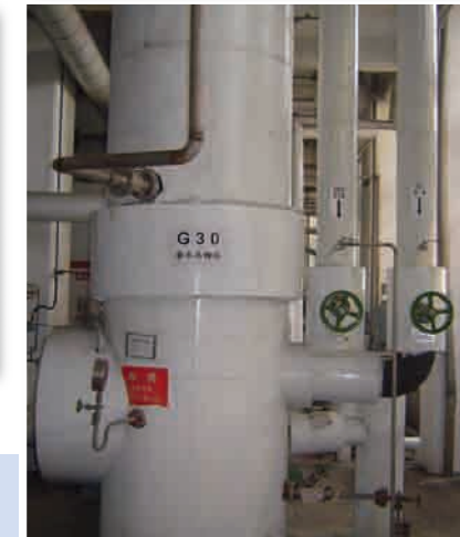
蒸餾塔熱能回收改善
