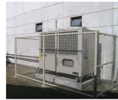
健康休閒中心熱泵主機
