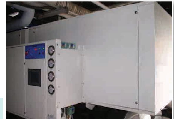
大型冰水主機
