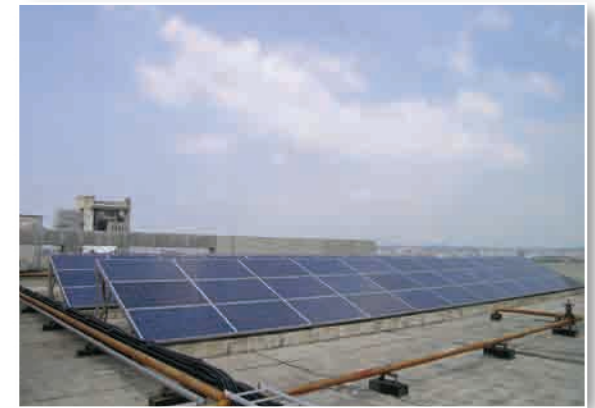
七館太陽能光電發電-光電板
