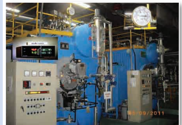
老舊鍋爐改低耗能高效率鍋爐及降壓運轉
