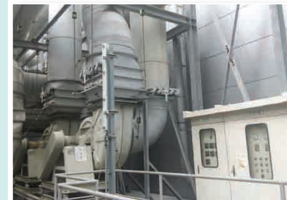
水排氣風車節能推動
