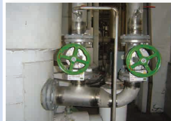
蒸餾塔熱能回收改善-2
