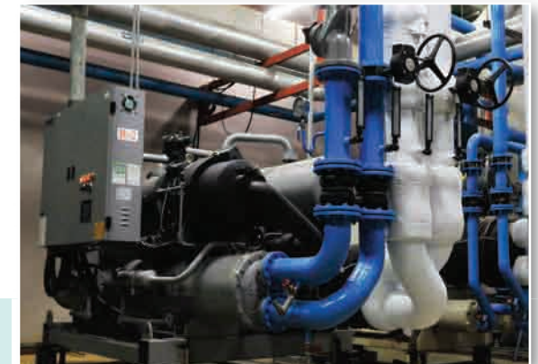
南館高效滿液螺旋冰水主機更新
