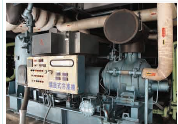
高效能螺旋式冷凍機
