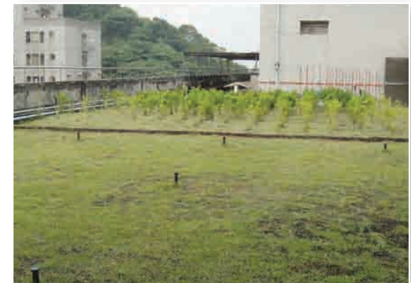
教學大樓頂樓隔熱裝置示意圖(6樓)實際現況
