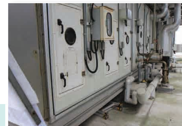
MAU再熱Heater關閉節能推動
