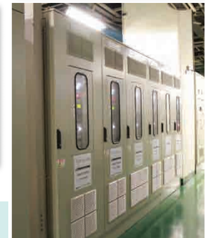
冰水最佳化_電盤
