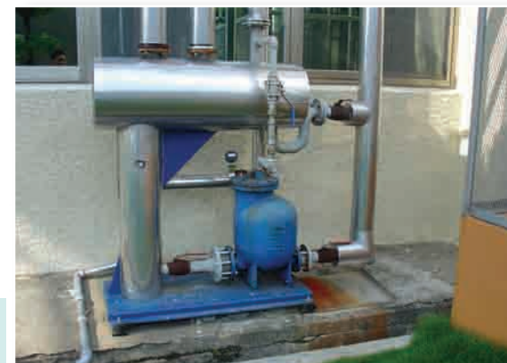
冷凝水回收設備泵浦
