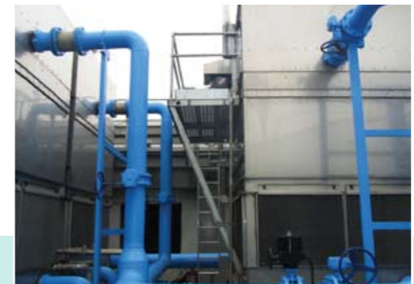
冷卻水塔更新
