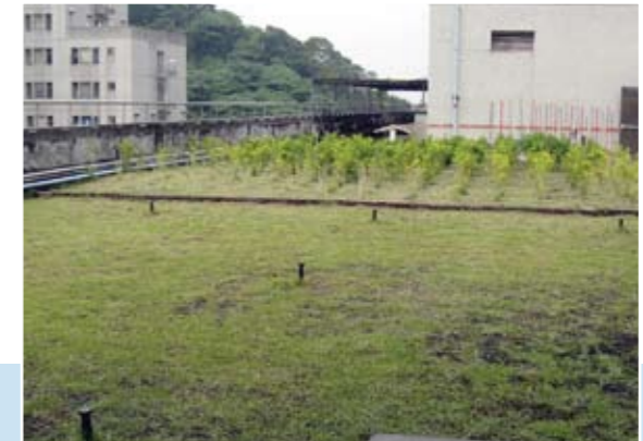
教學大樓頂樓隔熱裝置
