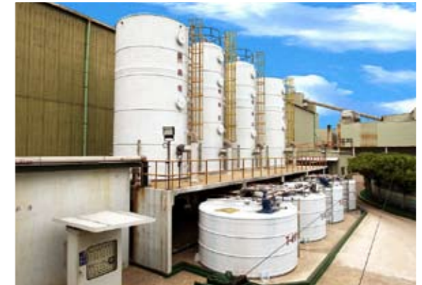
沼氣純化設備
