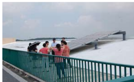
建築物屋頂設置太陽能光電板
