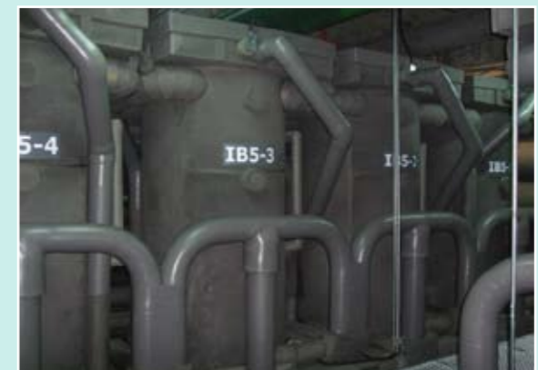
空調儲冰系統製冰機更新
