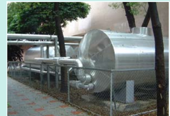
溫水游泳池熱泵系統
