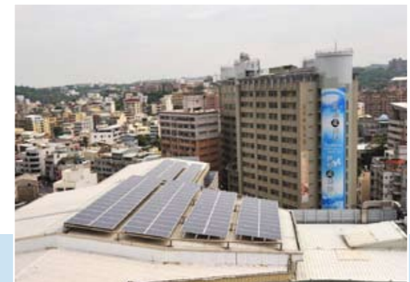
太陽能發電系統
