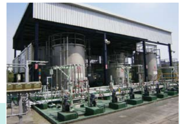
廢溶劑取代柴油作為輔助燃料(廢溶劑貯槽)
