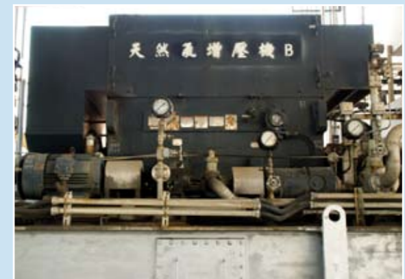
四號機天然氣增壓機停用之節能改善
