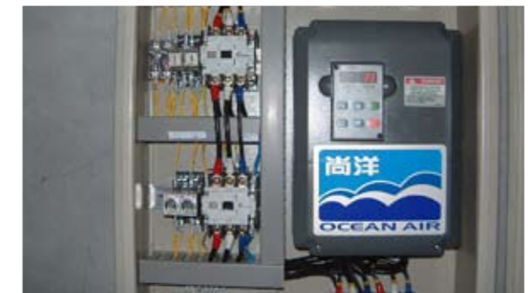
冷氣空調變頻器安裝
