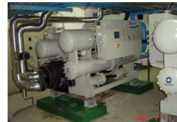
單身宿舍冰水主機汰換
