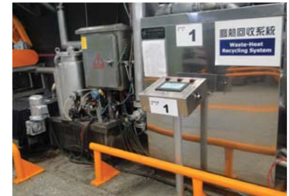
廢水熱能回收機
