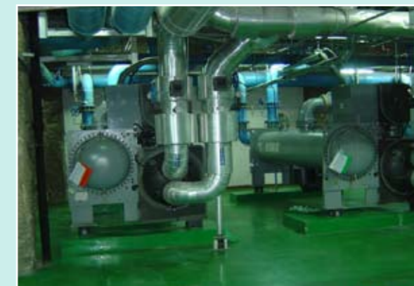
醫療及門診大樓冰水主機汰換
