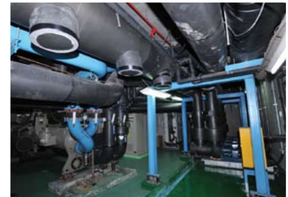
冰水機一次側變流量系統
