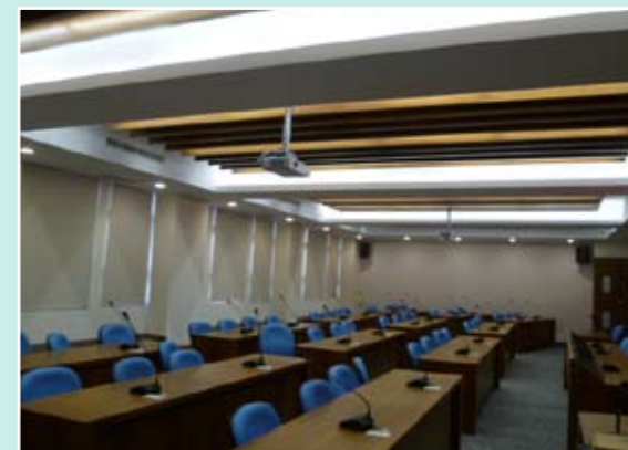
行政大樓A505會議廳LED照明燈實景
