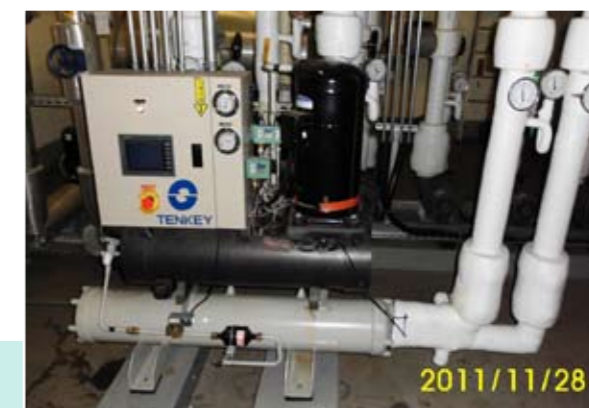
急診大樓熱泵系統
