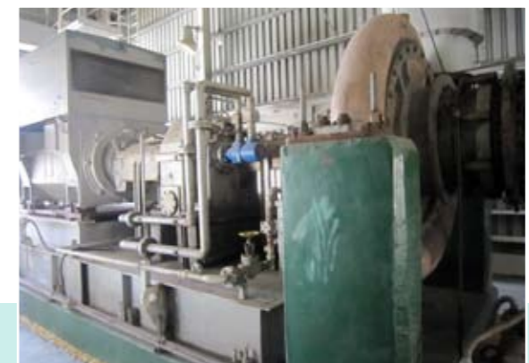
B501空壓機入口風門調整改善
