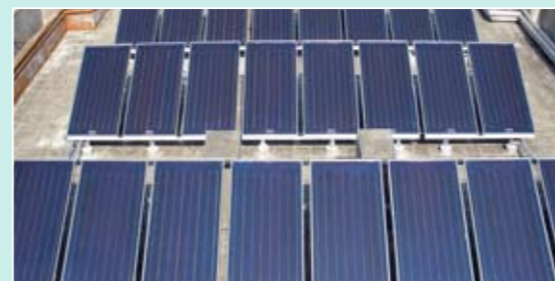
頂樓太陽能熱水器集熱板實景
