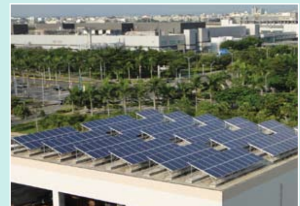
太陽能發電系統(太陽能板)
