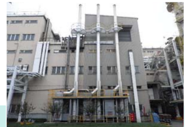
鍋爐排氣廢熱回收
