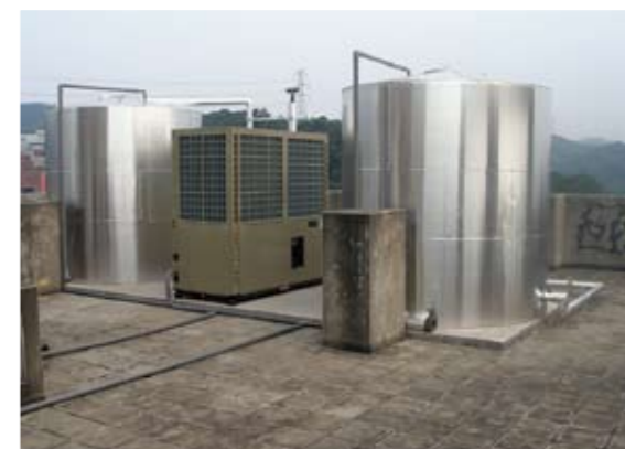
宿舍更換熱泵系統
