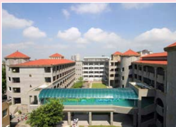
斜屋頂設計兼具隔熱及雨水回收
