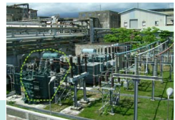
增設TR2變壓器-增加台電受電容量-停用復水式發電機
