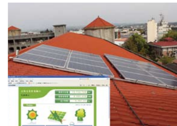
太陽能光電系統：透過網路回傳數據，用於實際教學
