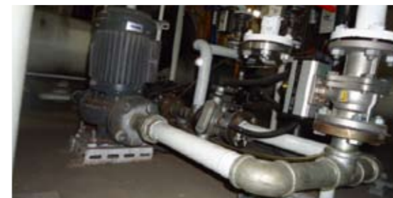
冷凍機冷凝器自動清洗裝置
