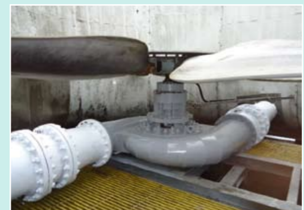
冷卻水塔風車改為水渦輪式
