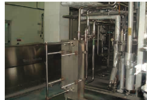
管式殺菌機加裝板式熱交換器節能案
