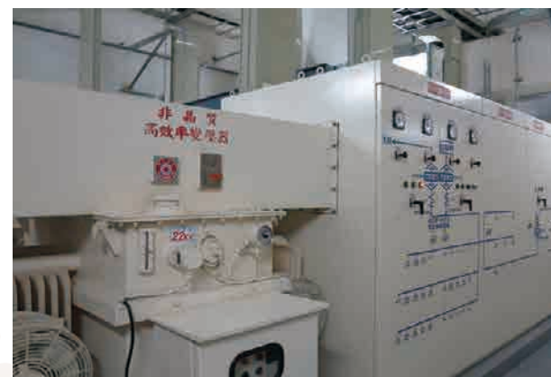
非晶質高效率變壓器
