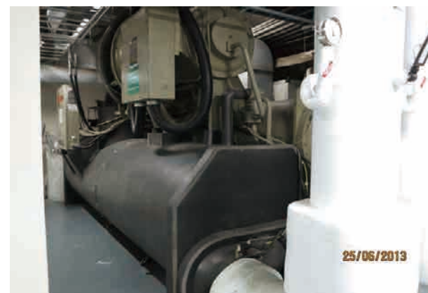
冰水主機汰換推舊換新
