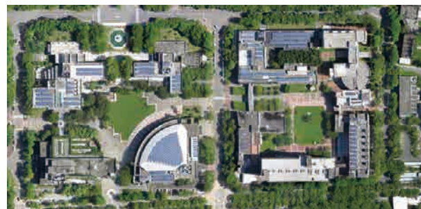
屋頂太陽能發電系統空照圖
