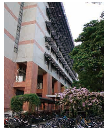
工程三館南向 立面外遮陽
