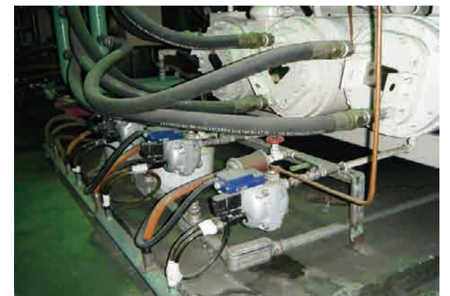
空壓機汰舊換新 (2)
