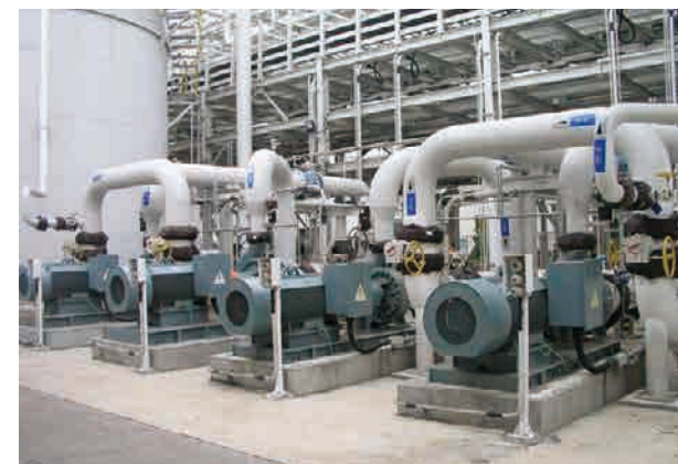
淡鹽水熱回收系統 - 泵
