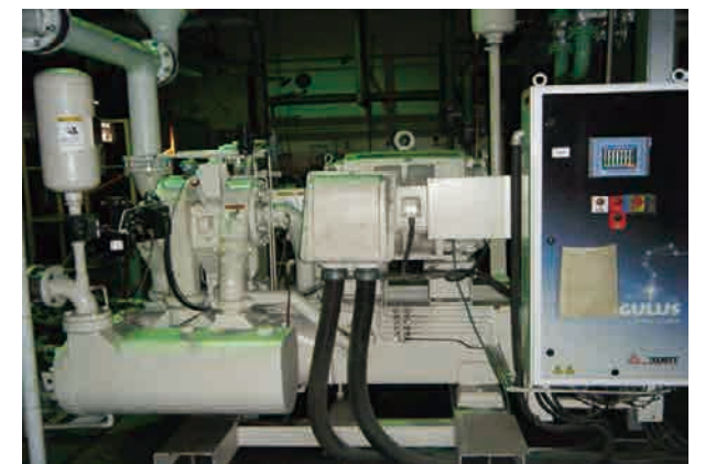
空壓機汰舊換新 (1)
