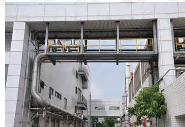
跨棟空調冰水管路合併
