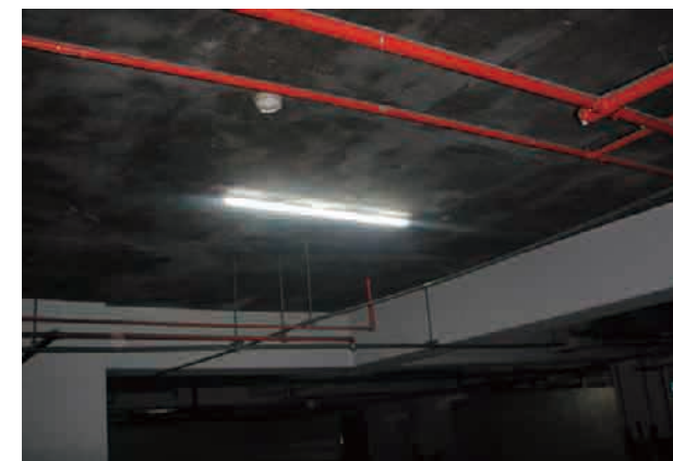
地下室停車場更換 T5 燈具
