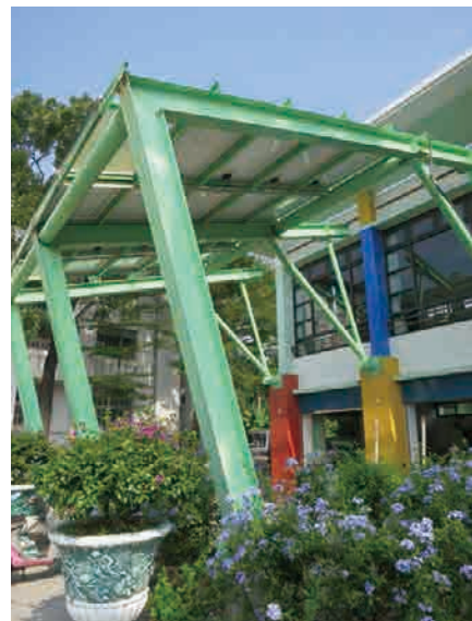
圖書館太陽光電系統外遮陽裝置
