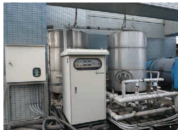
雙效型熱泵系統
