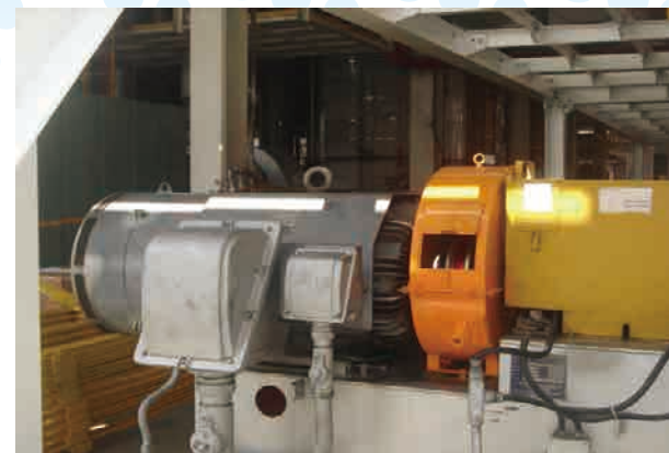
永磁聯軸器風車節能
