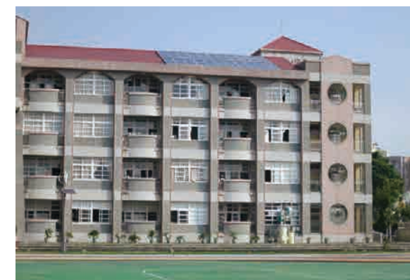
篤行樓屋頂建置太陽光電發電系統
