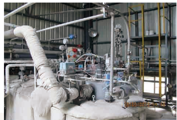
熱煤鍋爐燃油改天然氣
