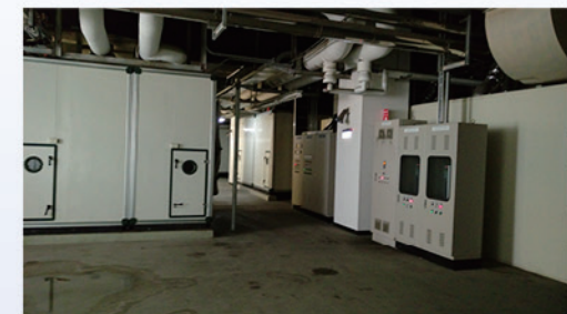
MAU&RCU 等 23 台空調箱節能改善 - 空調箱新增變頻器
