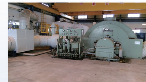
回收蒸汽投入汽機增加自發電量
