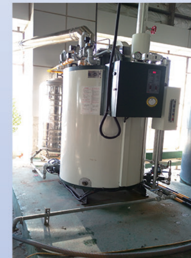
鍋爐瓦斯節能改善 - 新增 Local 鍋爐以降低主系統鍋爐壓力
