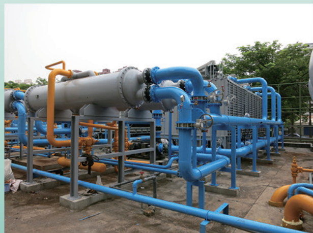
戶外冷凝水塔更新
