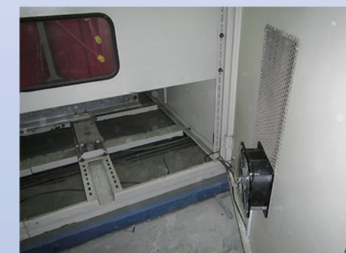
變壓器負載匹配與加強通風效果
