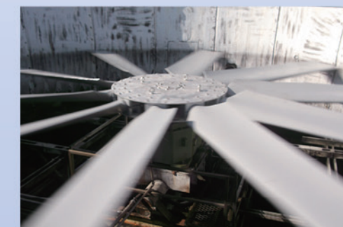
冷卻水塔更換節能葉片
