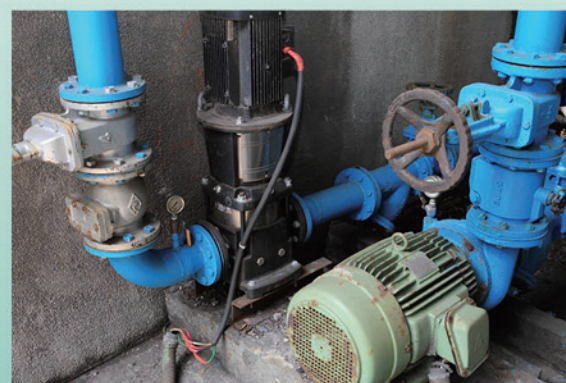
依實際需求調整泵浦馬力 - 檢視計算實際需求調整餘度，降低泵浦馬力數
