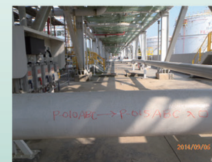
P010_P015 入口配管連接
