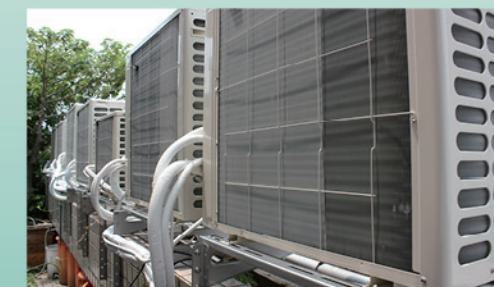
空調汰換 - 新空調室外機
