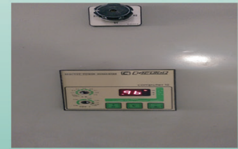
功率因數調整 - 加裝電容器提升用電效率
