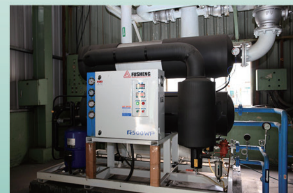
檢測數據進行空壓系統整合 - 精算實際需求風量後整合乾燥機減少台數
