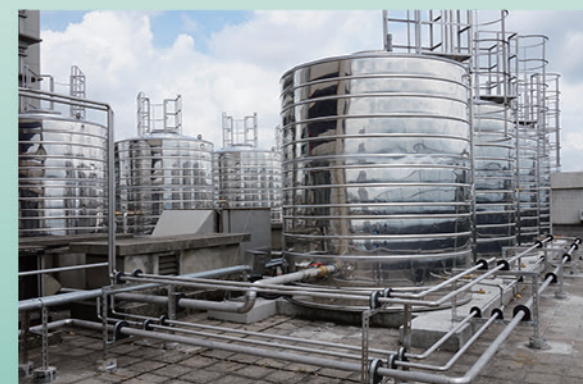
熱泵熱水供應水塔
