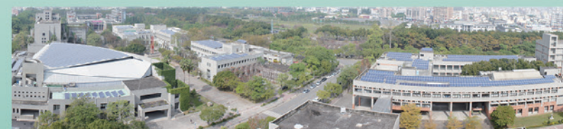
屋頂太陽能發電系統
