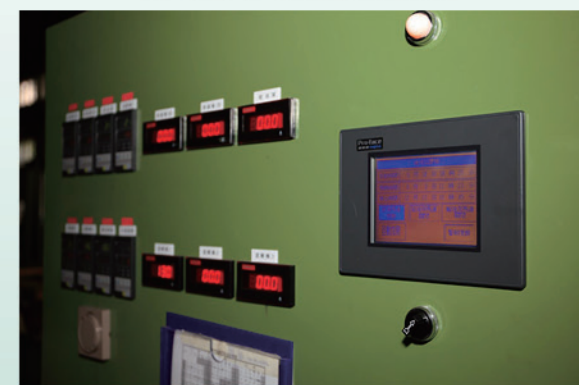
自動化管理預熱時間 - 熔膠機原為全天預熱，新增預熱時間預設功能
