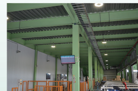
照明改善 - 自動倉儲水銀燈照明改 LED 燈
