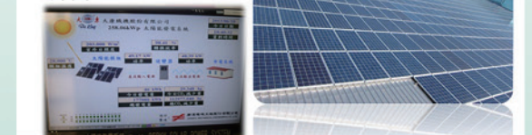
太陽能發電系統
