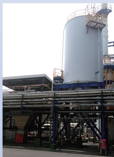
增設碳沉法取代焚化爐，增加廢觸媒回收量及節省燃料及蒸汽用量
