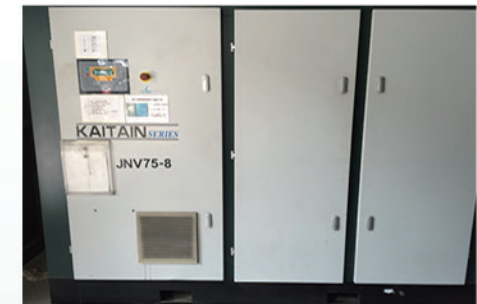
空壓機節能改善 - 全面由往復式更改為螺旋式
