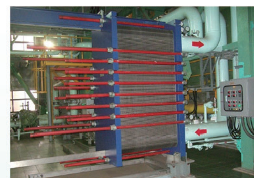
冷卻水系統改善 - 板式冷卻器
