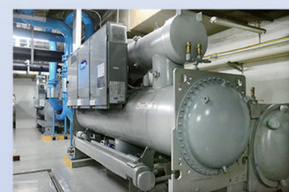
採用高效能變頻式冰機與泵浦系統
