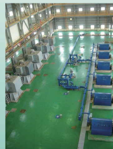
海水攔污沖洗泵改善 - 海水泵室
