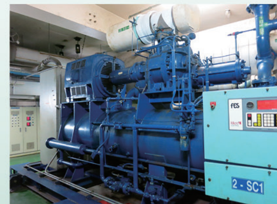
汰換儲冰冷凝系統
