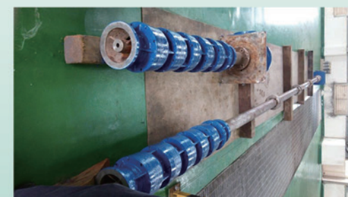
海水攔污沖洗泵改善 - 沖洗泵泵軸
