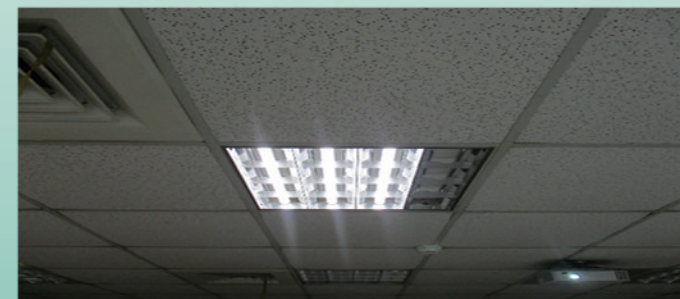
照明改善 - 採用 LED 燈管，且減少燈具數量達到節能效果
