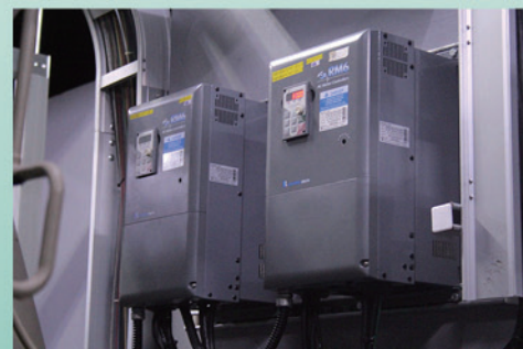
空調冰水系統全面裝設變頻器
