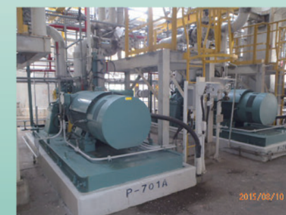
P701AB 泵送量因流程改變而減少
