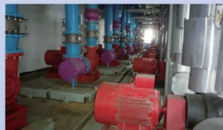
熱媒鍋爐瓦斯電力節能改善 - 熱媒鍋爐泵浦新增變頻器
