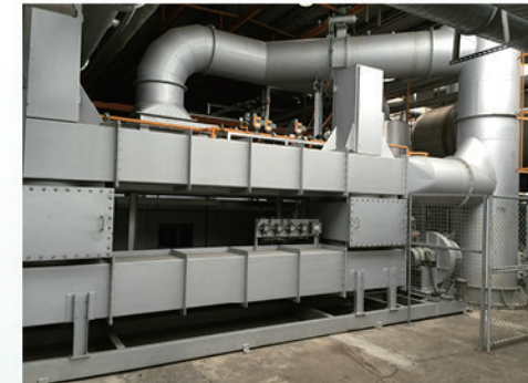
VOC 廢熱回收設備
