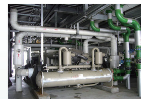
冷凍水系統由二階改一階
