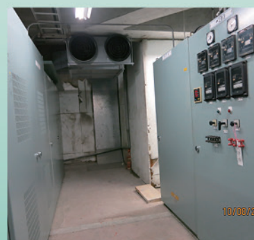
變電站改設夜間通風降溫節電
