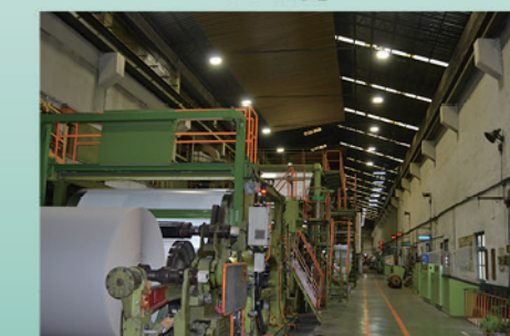
照明改善 -13 號紙機 T8 燈管照明改 LED 燈
