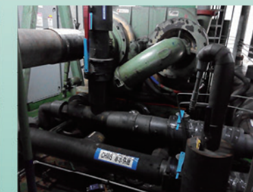
空壓機廢熱回收 - 增設暖水管路回收廢熱
