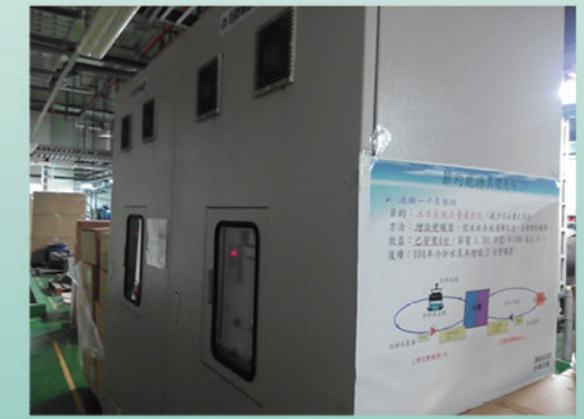
冰機一次泵變頻 - 增設變頻器使流量最佳化
