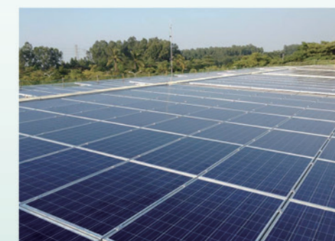
停車場屋頂設置太陽能發電系統
