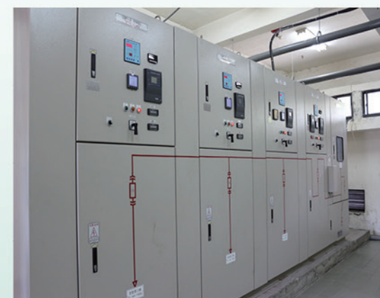
高壓電力節能改善工程
