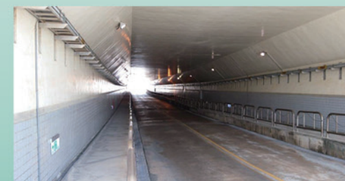
照明改善 - 車行地下道燈具
