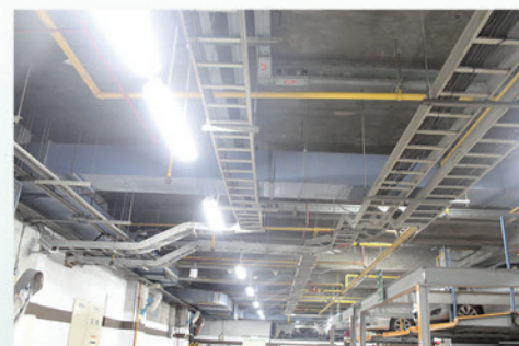
停車場照明燈換裝 LED 燈具
