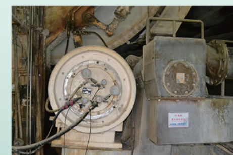
電力能源改善 -15 號機抽吸矽包膠由橡膠改為新型 PU 材質
