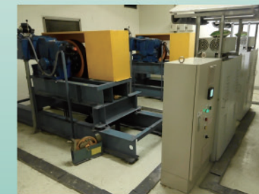
電梯電能回收 - 加裝節能櫃回收電能
