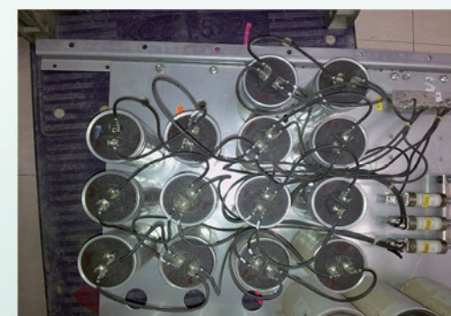
UPS 電容器改善 - 電容器組
