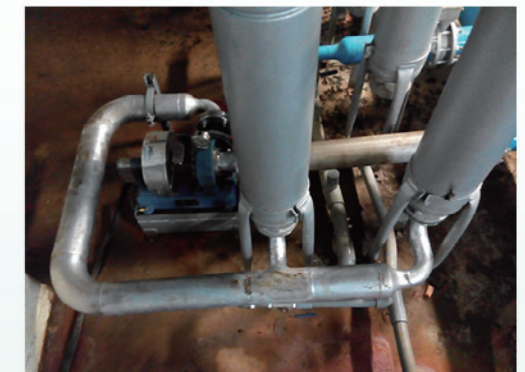
水力發電 - 自來水入水管安裝發電設備
