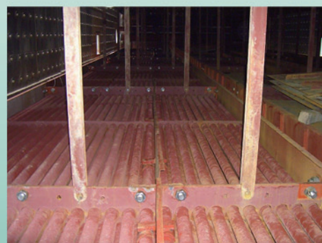
熱回收鍋爐改善 - 爐管
