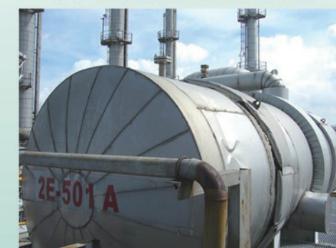
製程廢熱排放管路增設熱交換器以加熱蒸汽鍋爐飼水
