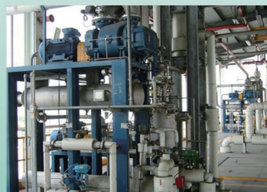
以真空泵浦取代蒸汽噴射器
