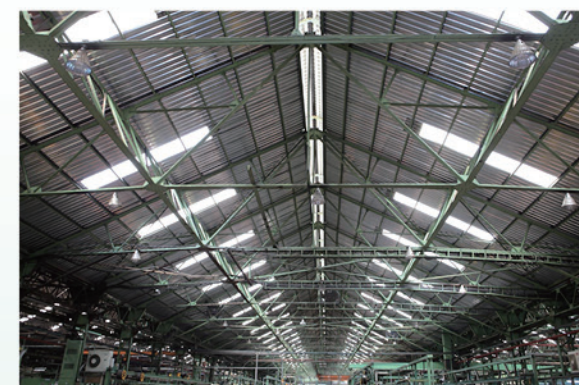
自然光源與廠房照明定時切換管控 - 開設屋頂透光罩白天不用開啟廠房照明
