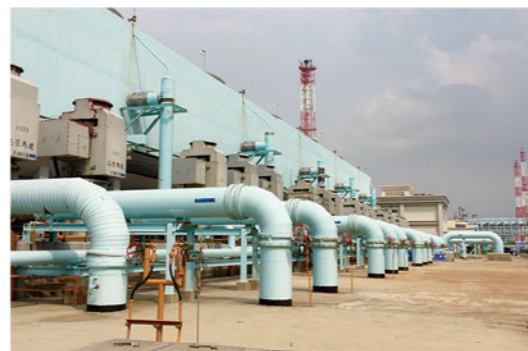
冷卻水塔節電 (高壓循環水泵)
