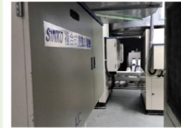
熱泵機房左側取熱洗澡用 x4 台 右側專供暖氣用 x2 台
