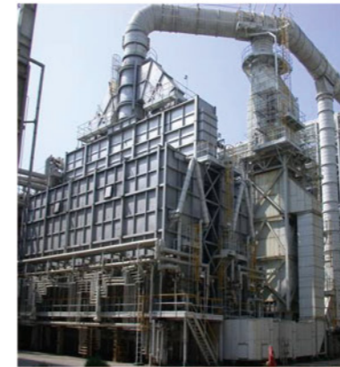
真空蒸餾單元加熱爐管注入蒸汽減量改善
