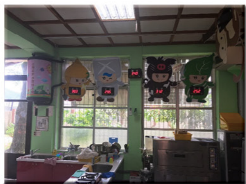
電力監控系統
