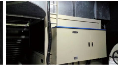
1 號熱泵主機取冷供客房用，取熱供洗澡用
