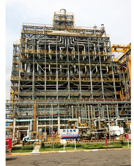
中油林園石化廠三輕更新 (裂解爐)
