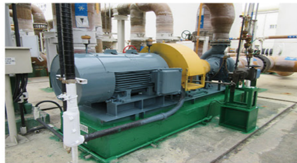
粗鹽水泵浦永磁式調速器節電
