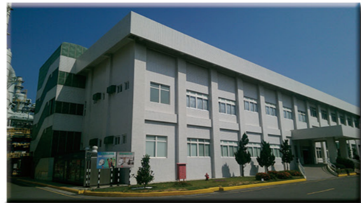
台灣化學纖維苯乙烯三廠 (103 年節約能源績優良傑出獎)
