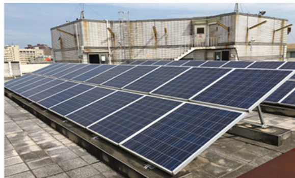
土木系設置 12kW 太陽光電系統
