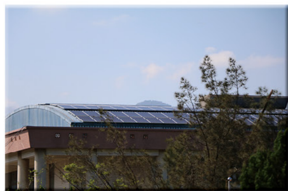
建置太陽能發電系統
