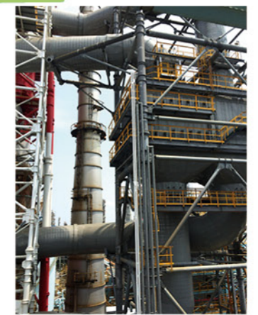
石化廠廢熱回收 (熱管換熱器)
