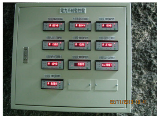
醫院增設電錶有效管理用電
