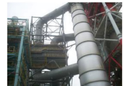
石化廠廢熱回收 (熱管換熱器)
