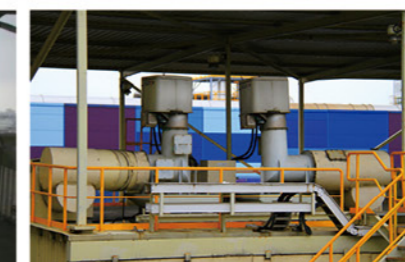
第一、二室改為高頻變壓器
