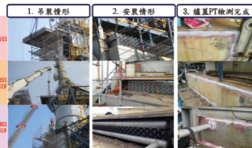
加熱爐增設節熱器施工圖
