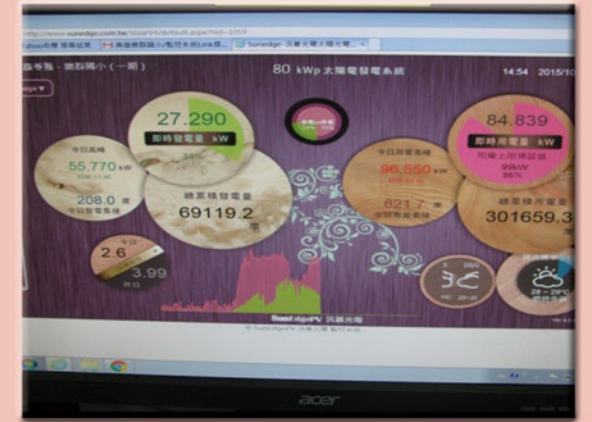
智慧發電與用電監控系統
