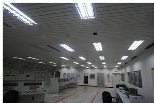
八里焚化廠照明改善
