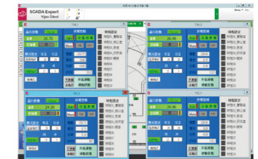
空調智慧管理監控系統節能改善 - 空調監控畫面
