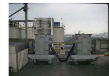
原第一、二室傳統變壓室
