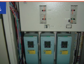
高齡醫學大樓與建時空調箱即附加設變頻器，另外氣預冷空調箱，採用 CO 2 程控，以最佳化運轉，達節能效果。
