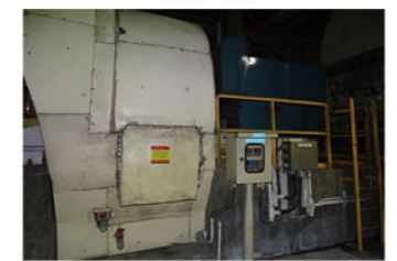
鍋爐一次風車葉輪改善
