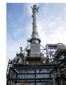
加熱爐增設節熱器改善
