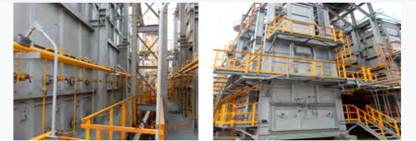
裂解爐更換 32 盞 100W 水銀燈為 40W LED 燈
