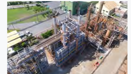
更新後裂解爐
