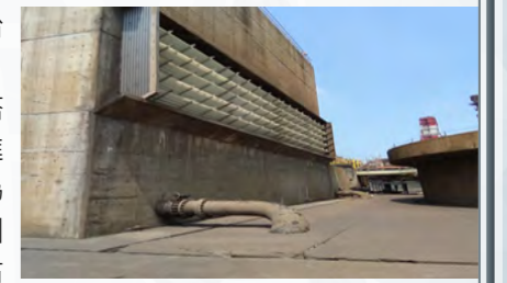
高爐洗塵水冷卻水塔改善
