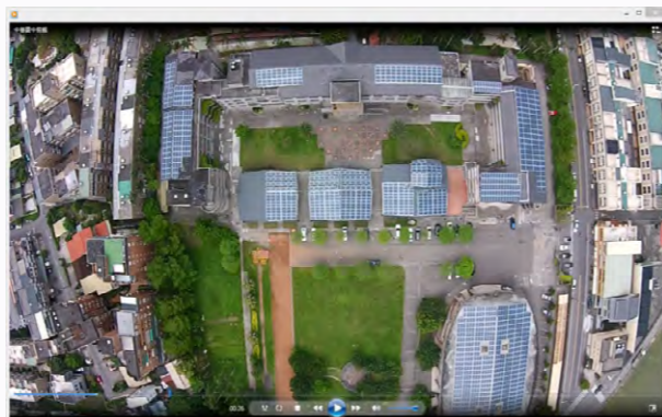
本校屋頂裝設太陽能板，總面積 3300m 2 ，為宜蘭縣裝設太陽能板面積最大的學校。
