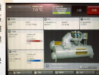
依外氣自動調節出水溫度 (7~9℃)
