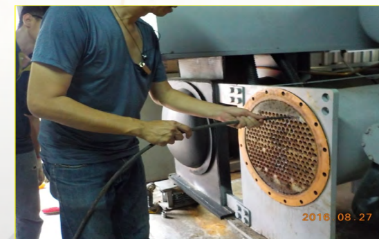
醫療大樓空調系統改善冷凝器傳熱
