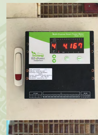
各樓層電力監控表
