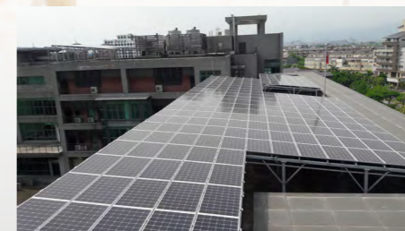
頂樓裝設屋頂型太陽光電設備
