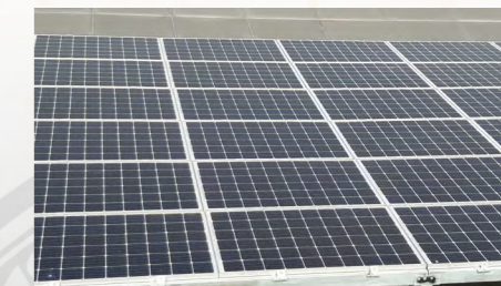
太陽能光電設備
