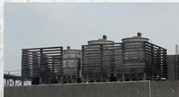
停用中央空調主機
