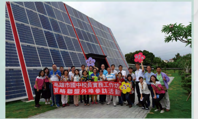
參訪太陽能光電設施
