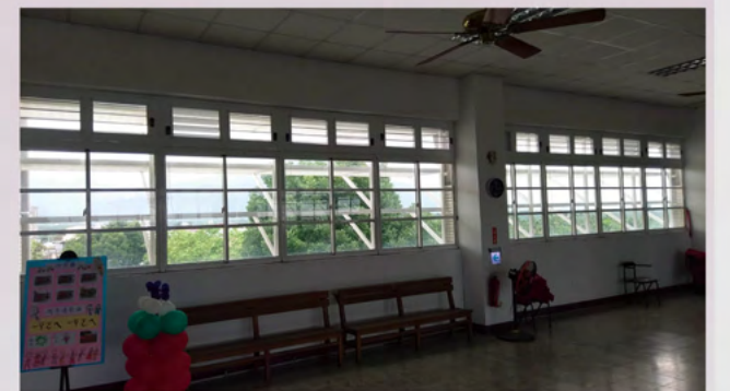
西曬教室裝設外遮陽設施
