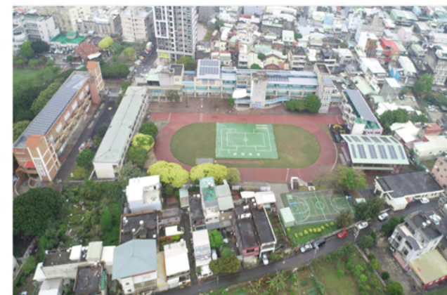
屋頂架設太陽能板
