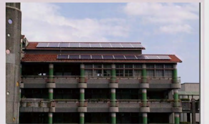
綠建築增設太陽能設施
