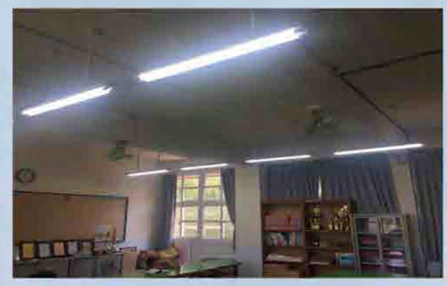
教室全面汰換為 LED 燈管
