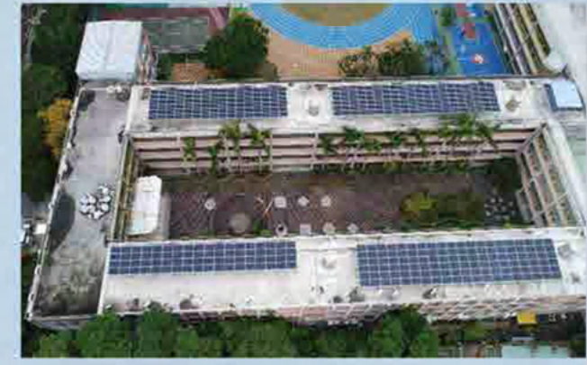
屋頂設置太陽能板
