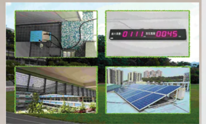
智慧校園節電措施 - 降溫水霧、智慧節電、節能遮陽板、太陽能發電設施
