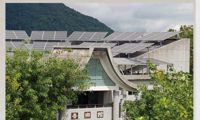
校舍屋頂裝置太陽能板
