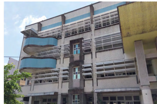
西曬教室裝設外遮陽設施
