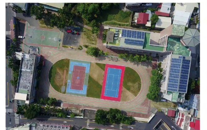
屋頂架設太陽能板
