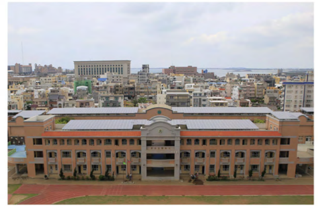
校舍頂樓太陽能發電基板
