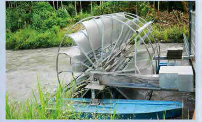
蘭陽發電廠 - 微型水力發電組
