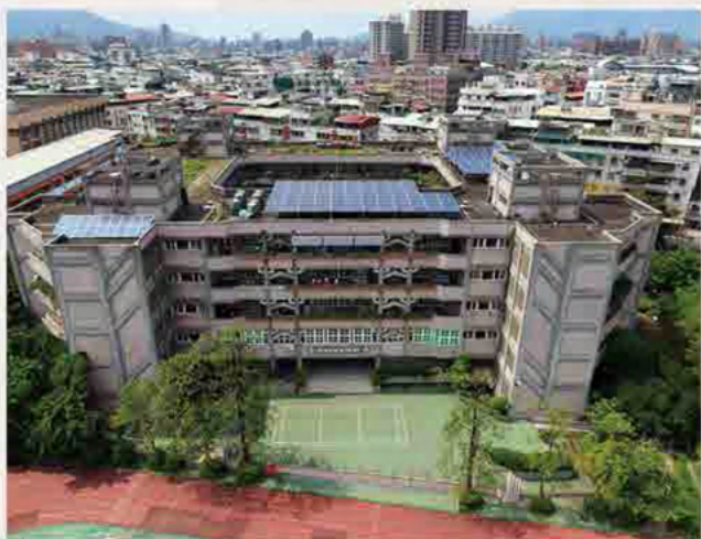
設置屋頂太陽能光電系統 (52kw)
