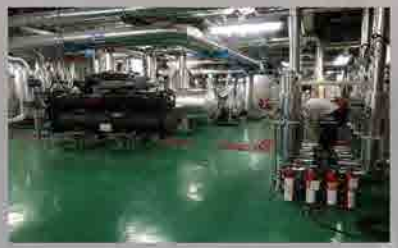
客房熱水改為熱泵加熱
