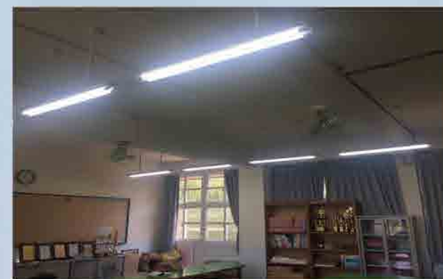
教室全面汰換為 LED 燈管
