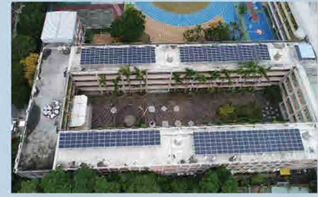
屋頂設置太陽能板
