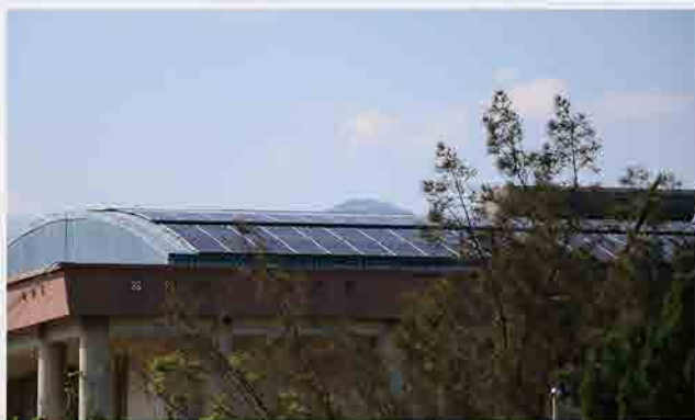
建置太陽能發電系統
