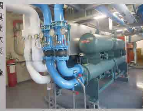
汰換之變頻冰水主機
