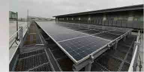
屋頂設置太陽能光電
