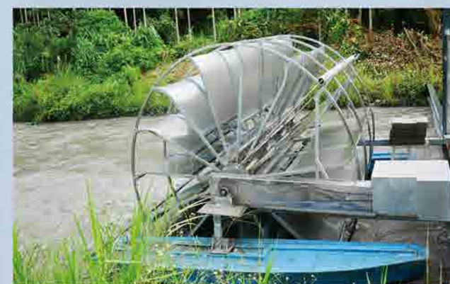
蘭陽發電廠 - 微型水力發電組
