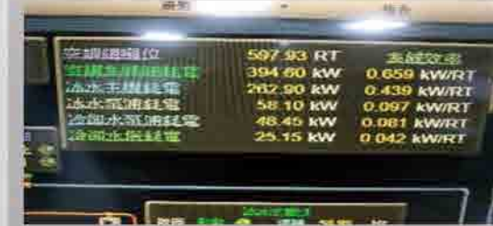
冰水系統運轉效率即時管理
