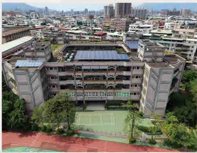
設置屋頂太陽能光電系統 (52kw)
