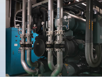
冰水管路控制系統
