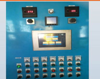
冷凍主機控制盤
