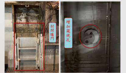
封閉加熱爐檢查門，增設窺視孔
