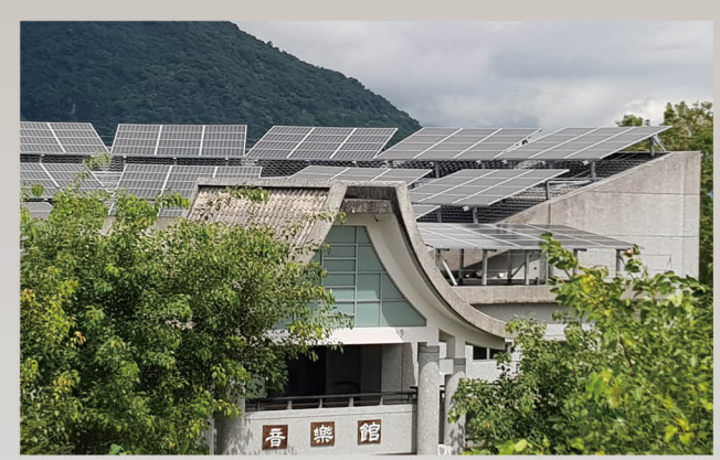
校舍屋頂裝置太陽能板
