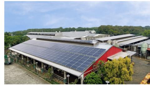
太陽能發電：第一期 300Kwp 發電量：379,910 度 / 年，後續將陸續分年投資興建新案場，有效降低牛棚溫度，減少降溫用電。
