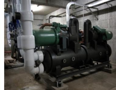
圖書資訊大樓更換高效率變頻冰水主機及建置智慧化節能控制系統
