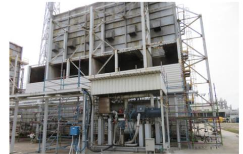
地面燃燒塔暖管蒸汽增設 ORC 發電機組系統
