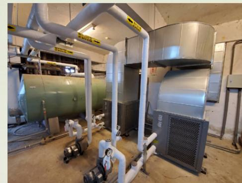
高效能氣冷式熱泵主機
