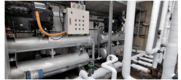
30RT 儲冰系統：充分運用離峰電力儲冰，供日間產線使用，有效降低開機前預冷消耗之電能。
