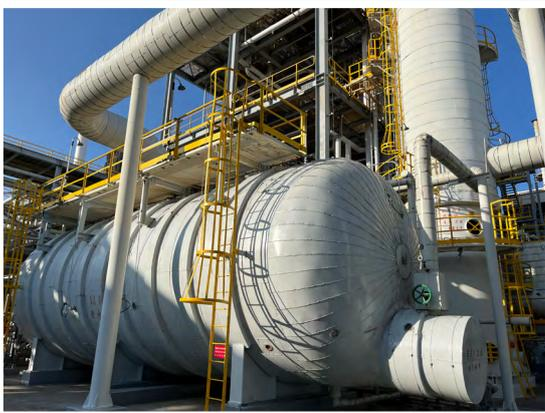
脫水塔更換高效率 TRAY 板節汽
