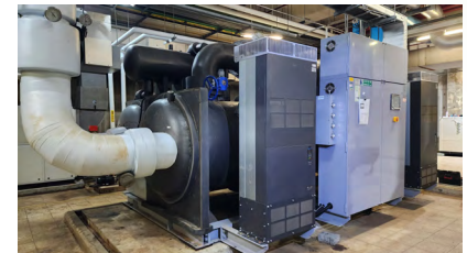
800RT 冰水主機換裝能效一級磁浮式主機 (第二台)
