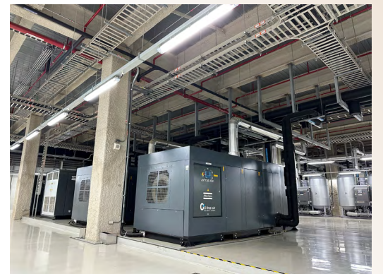
智能空壓機系統運轉最適化
