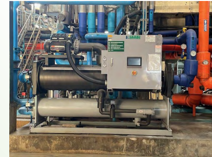
冰水主機設備汰換節能方案
