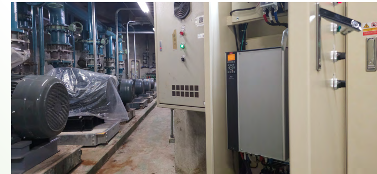
冷卻水泵 - 變頻控制裝置
