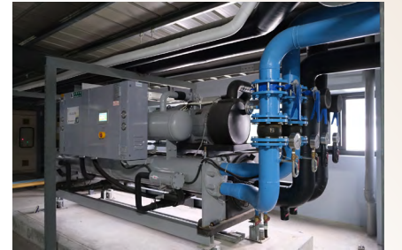
全面汰換 COP2.5 傳統冷氣，導入 COP4.8 冰水主機
