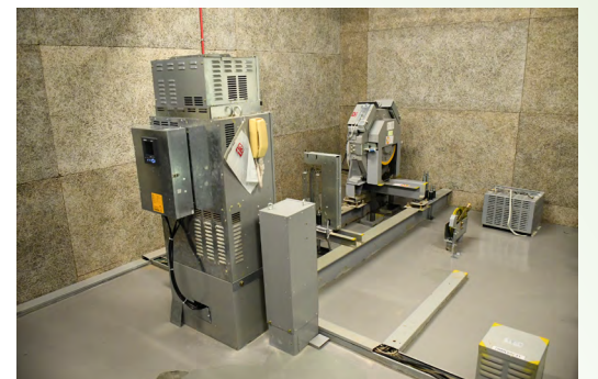
電梯加裝電力回生系統
