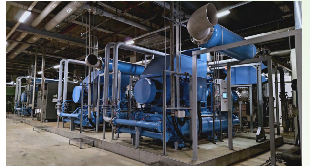
空壓機汰換節能機
