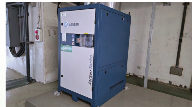
魯式鼓風機汰換離心式節能鼓風機
