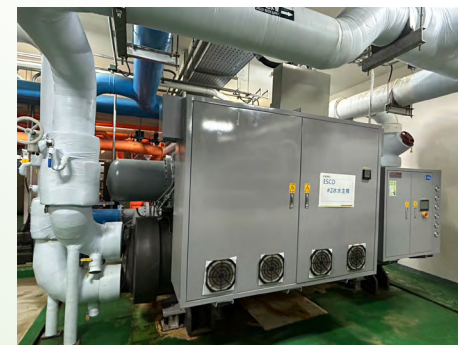
冰水系統優化 - 一級能效冰水主機
