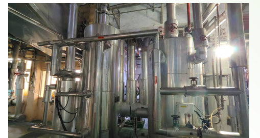
鍋爐連續排放熱回收系統 (三次熱回收)
