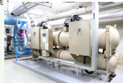
汰換空調主機為磁浮式主機
