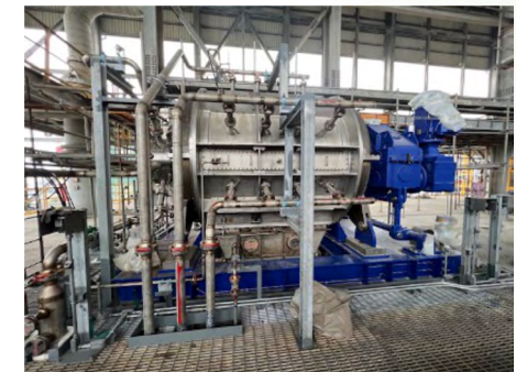
增設 CTA RPF(Rotary Pressure Filter) 專案 背壓式蒸汽壓降渦輪發電機組建置專案
