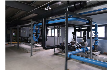
全面汰換 COP2.5 傳統冷氣，導入 COP4.8 冰水主機
