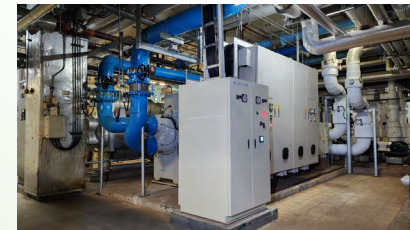
800RT 冰水主機換裝能效二級磁浮式主機 (第一台)
