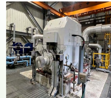
增設 CTA RPF(Rotary Pressure Filter) 專案 背壓式蒸汽壓降渦輪發電機組建置專案
